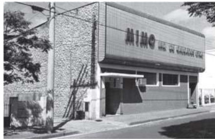
Fachada da Calçados Mimo em 1980
