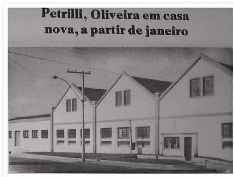
Novas instalações da Petrilli & Oliveira Indústria de Artefatos de Borracha Ltda, inauguração ocorrida em 10 de janeiro de 1977 na rua dos Fundadores, n° 404.
