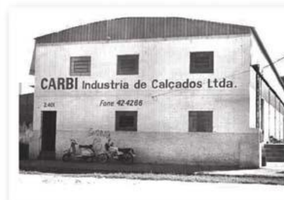
Fachada da Indústria e Comércio de Calçados Carbi Ltda na Avenida João Cernak, nº 2401, 1986.
