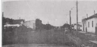
Abadia Abadez, estrada que terá melhores condições de acesso a Birigiti
