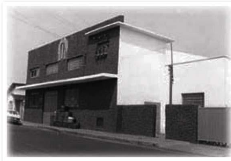
Fachada da empresa Rahal, Assumpção Cia Ltda (Rassum), década de 1970. Localização: Rua Maestro Antônio Passarelli, 283.
